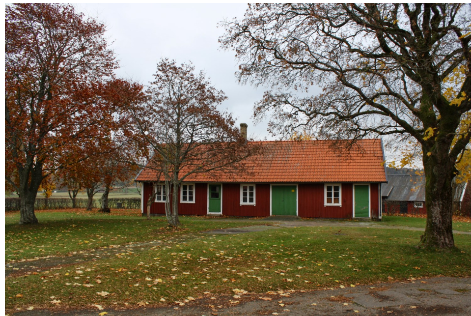
Stallbyggnaden utmed Tingsvägen är det enda byggnaden som är kvar av byggnaderna vid Årstads Häradsting i Heberg
